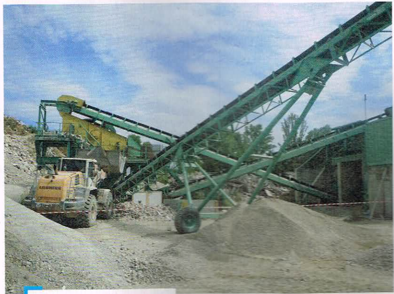
Plate-forme Audigier de recyclage des déchets BTP à Montélimar
